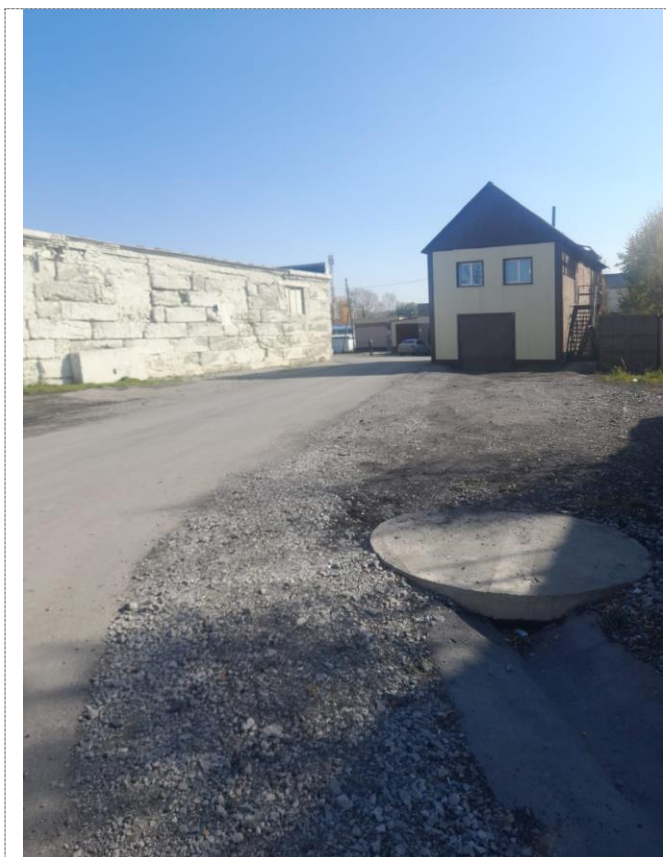
Фото №15 – Пути движения к объекту (от остановки транспорта)
